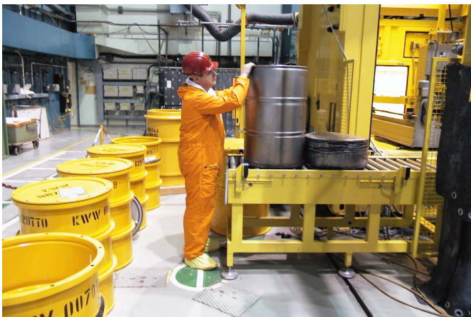
Abb. 3: Hochdruckpresse zur Verpressung radioaktiver Abfälle im Kernkraftwerk Würgassen. [11]
